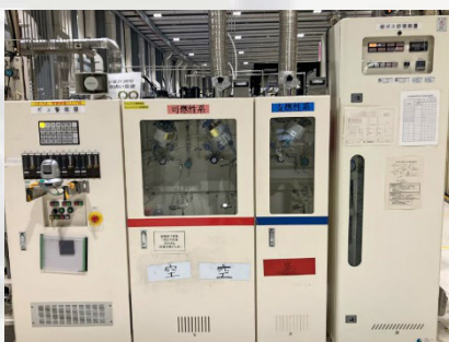
ガス取扱設備（共通設備） ガス雰囲気を試料に供給しながら計測を可能にする。ガスの供給と排気を安全な取扱いが可能
