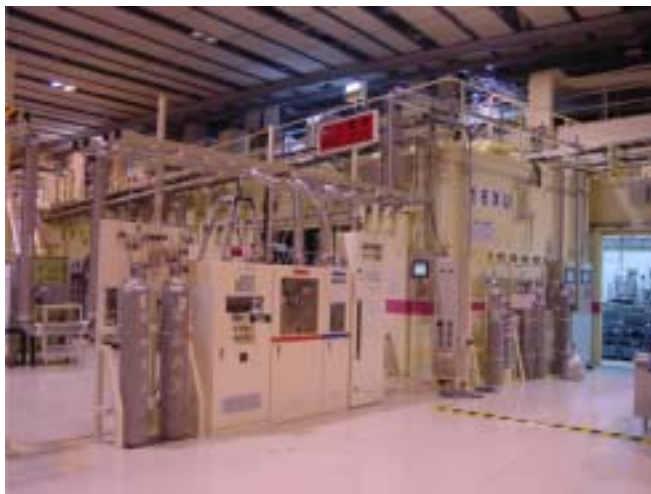
図 サンビームに設置したその場計測用ガス取扱い
